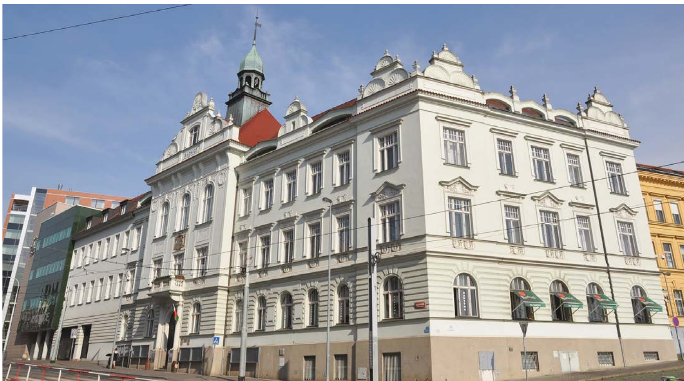
Úřad místní části Praha 9
